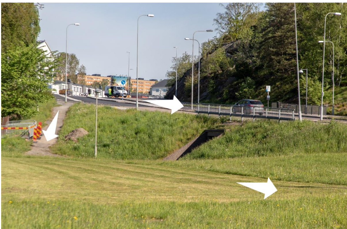
Figur 6 Perspektiv framför befintlig gångtunneln. Pilar visar flödesriktning vid skyfall. Pilen går uppåt på grund av att hela gångtunneln blir full vid ett klimatanpassat skyfall och då rinner vattnet vidare söderut. (Foto: Lina Ekholm).
